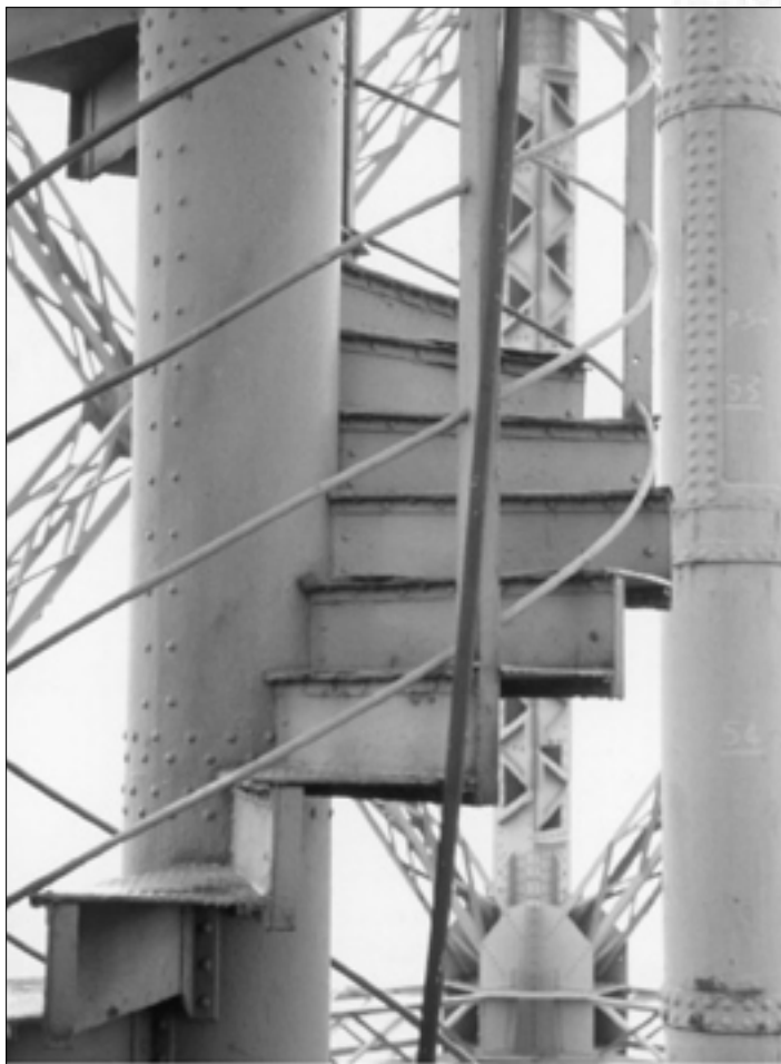
Escalier hélicoïdal conduisant du 2 e au 3 e étage démonté en 1983
