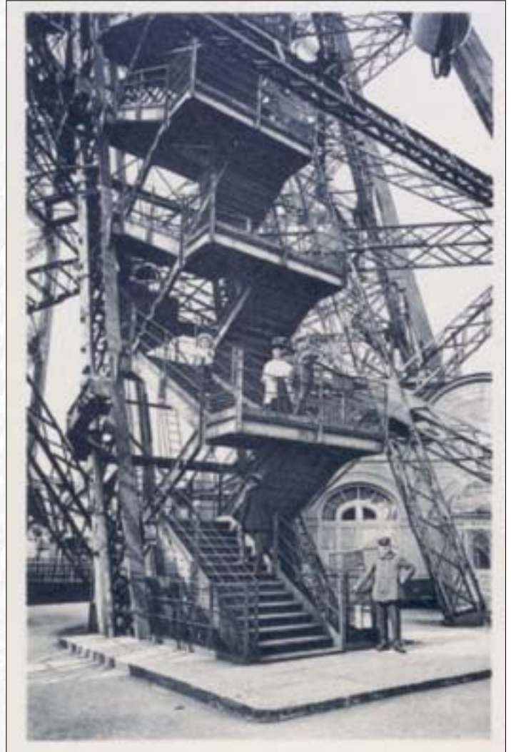
Escalier conduisant du 1 er au 2 e étage (357 marches)
